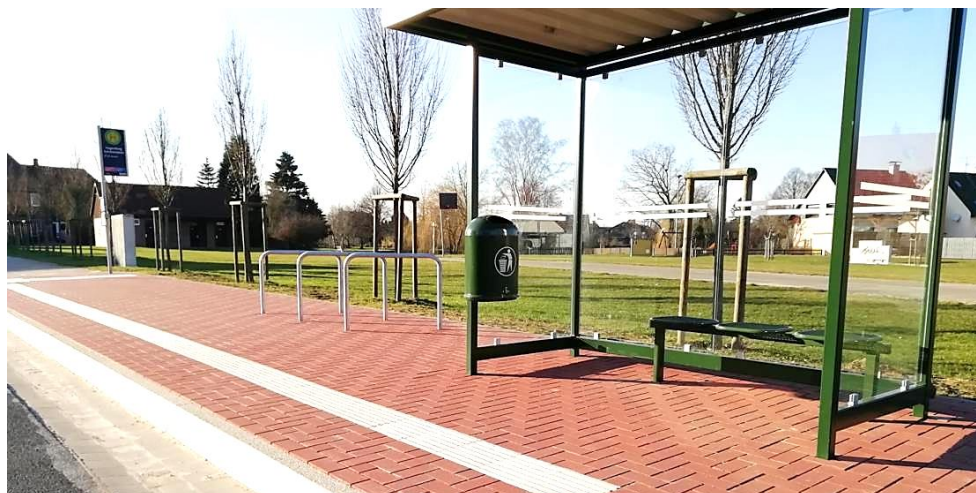
Abb. 51 Beispiel: Barrierefreie Bushaltestelle mit nicht überdachten Fahrradbügeln (Bildquelle: Region Hannover /A. Lehmann)
