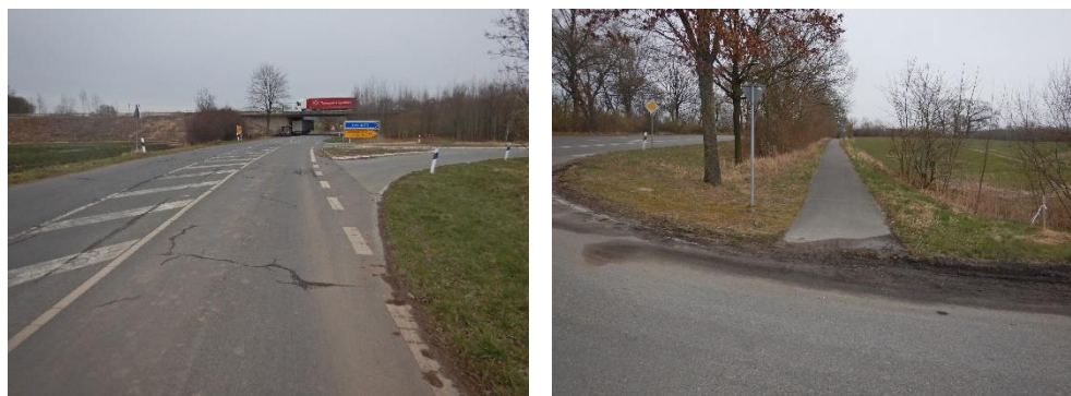
Abb. 47 L 296 westlich Mollhagen in Höhe B 404 und Radwegende an Bundesstraßenabfahrt
